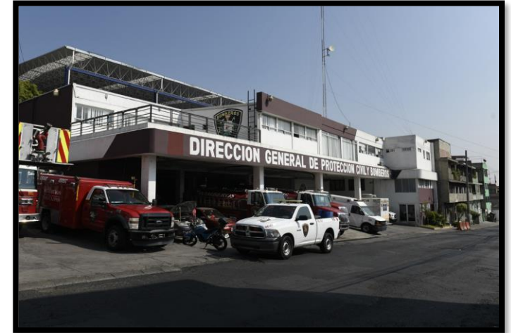
Rehabilitación de módulos de seguridad
