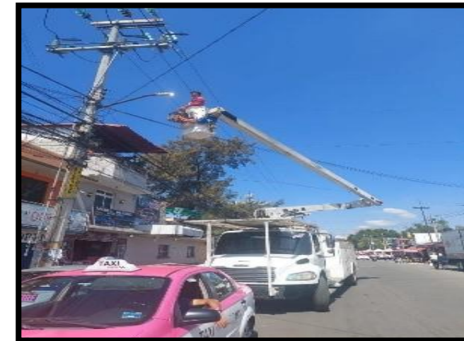
Instalación o sustitución de luminarias.
