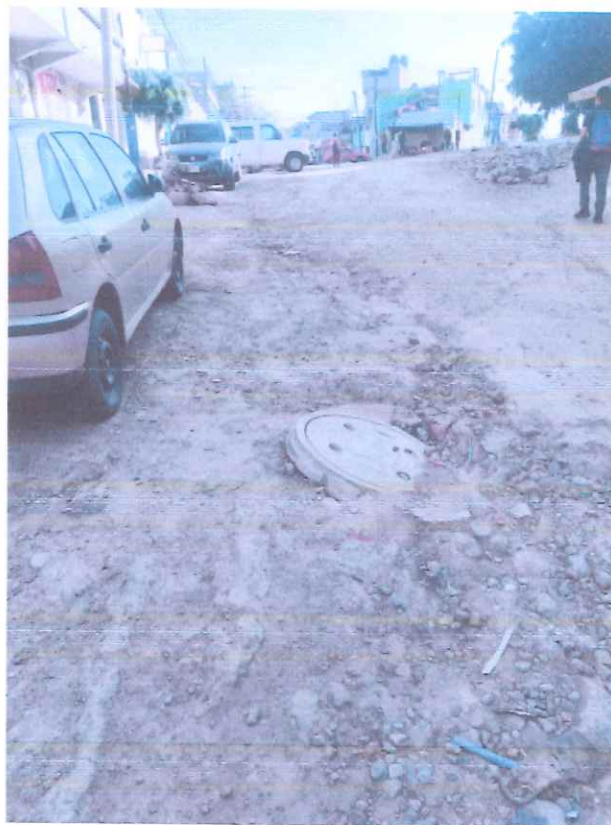
AVENIDA CENTENARIO: POZOS DE VISITA AFECTADOS POR PASO VEHICULAR
