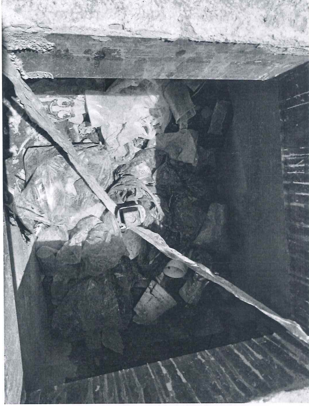
Caja de válvulas de agua potable, acumulación de basura, generando foco de infección
