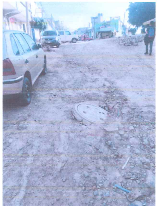
AVENIDA CENTENARIO: POZOS DE VISITA AFECTADOS POR PASO VEHICULAR
