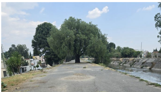
Imagen 7: Estado actual de avenida Las armas
