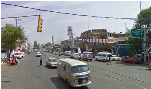
Imagen 45 Estado actual del tren ligero
