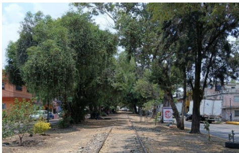
Imagen 11: Estado actual de las vías del tren
