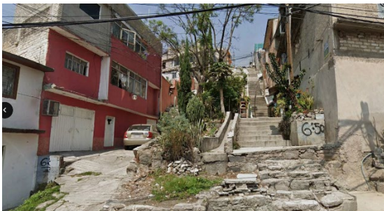
Imagen 35 Estado actual de pendientes y escaleras
