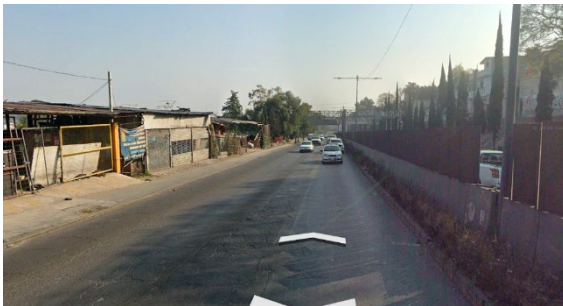
Imagen 23 Estado Actual de la Av. las Torres y 1° de Mayo
