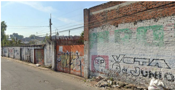
Imagen 51 Estado actual de las estaciones de Mexicable Línea 3
