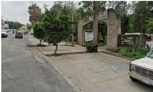
Imagen 29 Estado actual de Parque La Hoja
