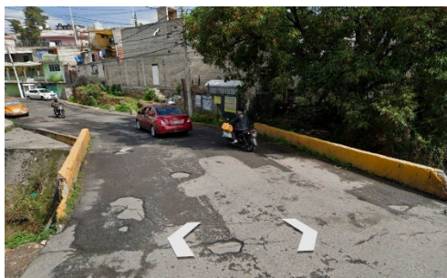
Imagen 21 Estado actual de Av. Minas Palacio
