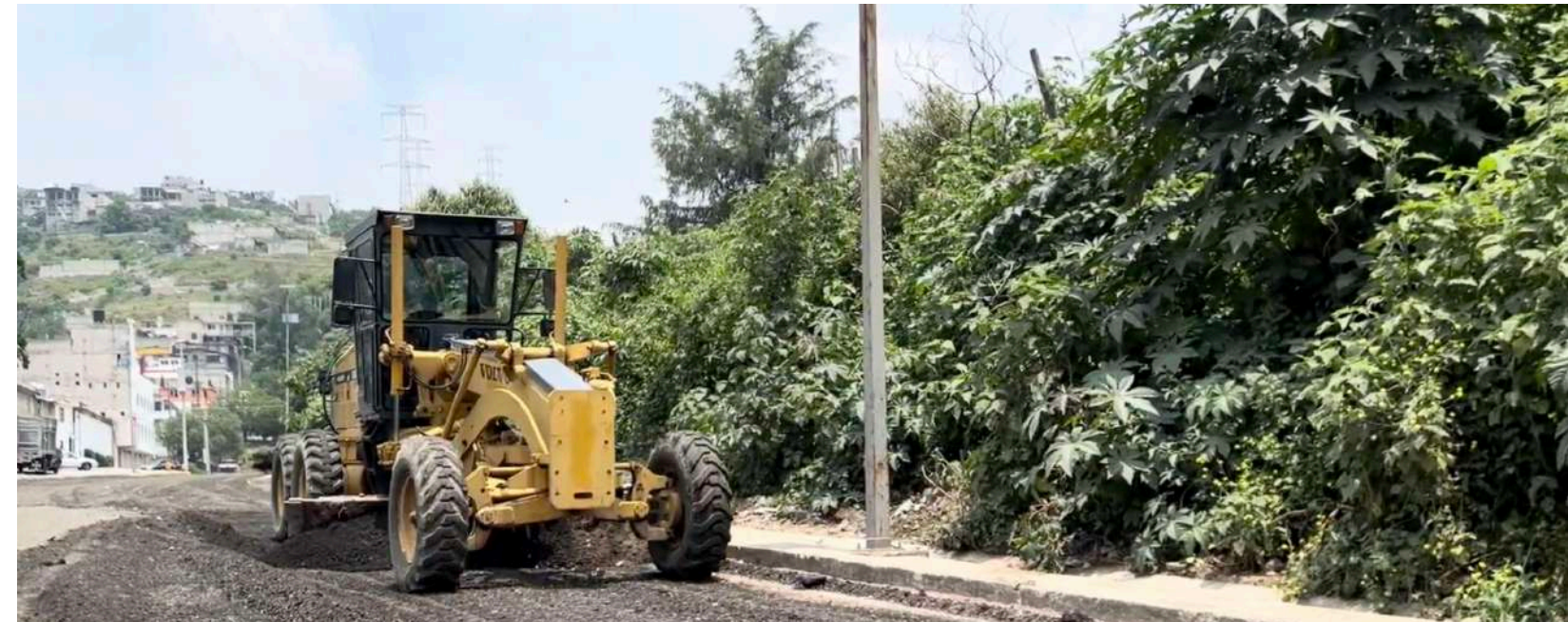
Avenida par vial San Mateo.Rehabilitación reutilizando material asfáltico producto del fresado (Triturado de carpeta asfáltica, producto de la rehabilitación, reciclando el material de desecho)
